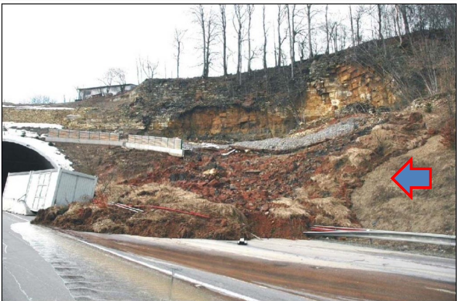
Východní portál tunelu 1.4. 2006, 14. hod. (foto O. Krejčí)
