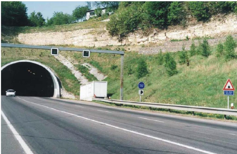
Východní portál tunelu v roce 2003 (foto S.Čech)
