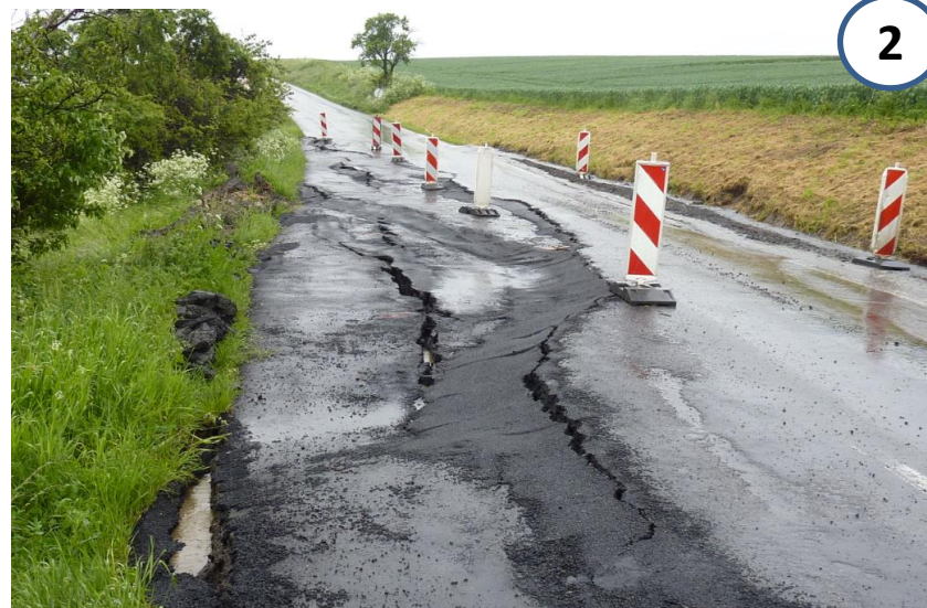
Silnice II. tř. Koryčany – Jastrabice, 2010. Foto: SUS ZLK
