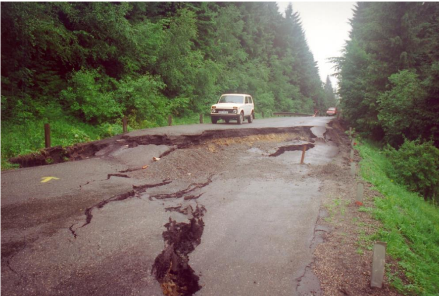
Sedlo Dušná, III/05735, Vsetínské vrchy. Foto: O. Krejčí, červenec 1997
